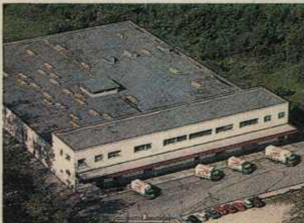
Stabilimento di Carapigna Mortaredo (Como): 5300 metri quadrati coperti ca.
