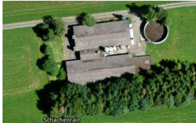
▲ Flugaufnahme der ehemaligen Schweinefabrik - gesetzeswidrig bewilligt in eine Gewerbeliegenschaft umgebaut.
