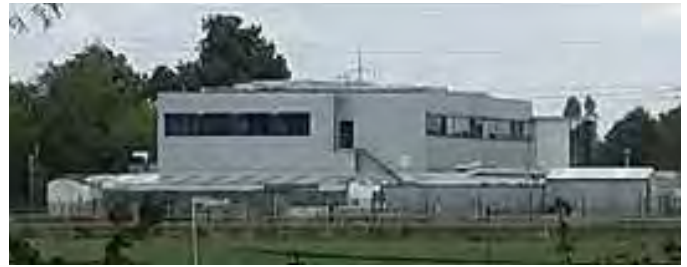
Oben: Covance-Terversuchsfabrik in Münster
