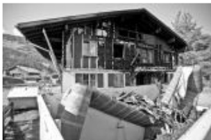
Das Jagdhaus des Novartis-Chefs im Tiroler Ort Bach wurde schwer beschädigt. Foto: epa
