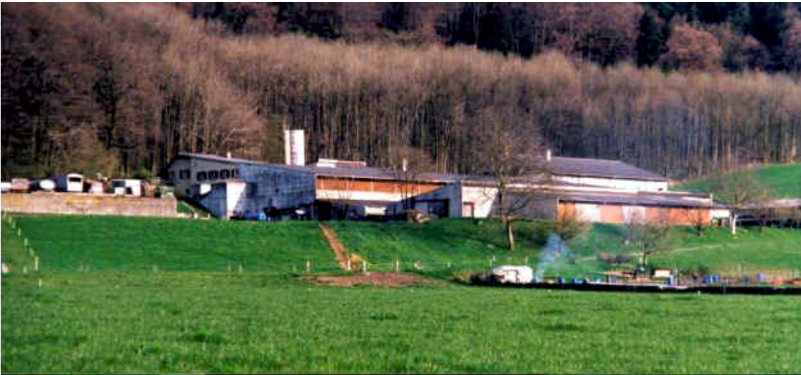
Schweinefabrik in Gretzenbach ( www.vgt.ch/vn/9904/gretzenbach.htm ):
